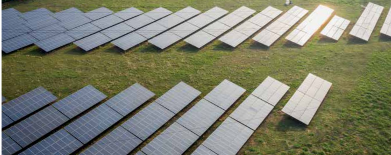
Celsia Solar Yumbo Valle del Cauca, Colombia
